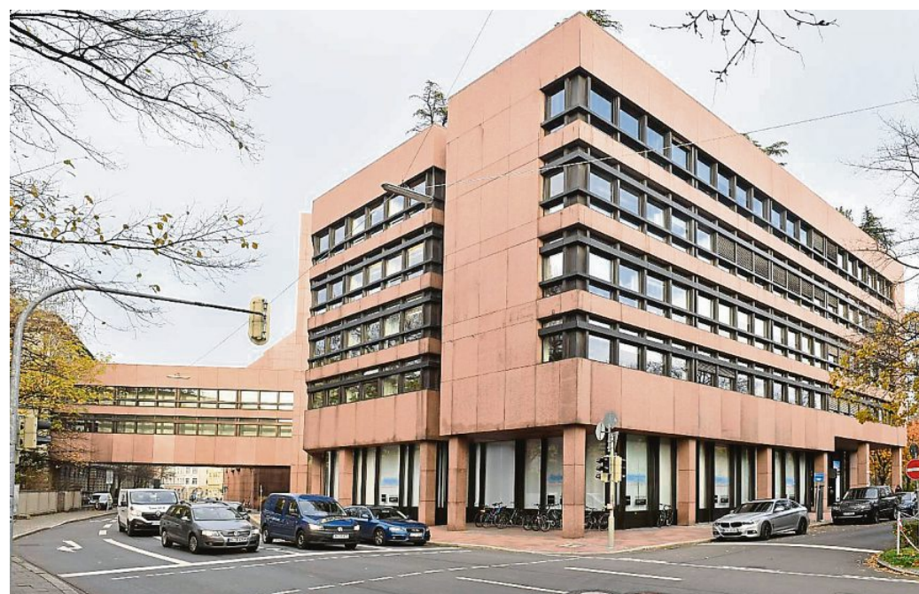
Ein Produkt seiner Zeit: Das Verwaltungsgebäude der Bayerischen Versicherungskammer an der Kreuzung Maximilian- und Sternstraße wird abgerissen. FOTO: MARCUS SCHLAF
